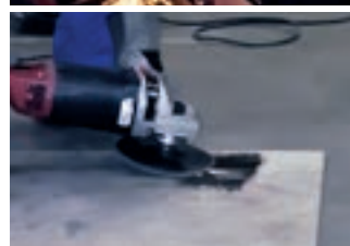
Regularização de defeitos
