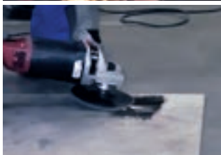
Regularização de defeitos
